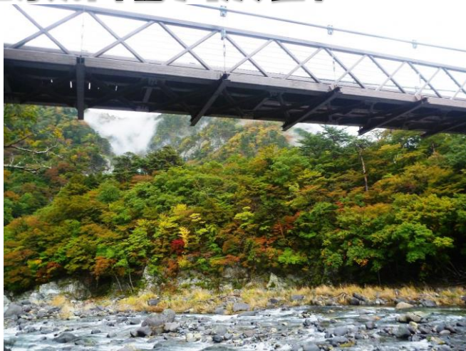
七ツ岩吊橋（塩釜温泉地区）
