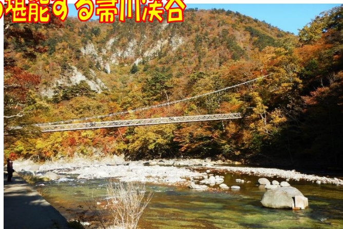
箒川渓谷「七ッ岩吊橋」付近の渓谷の紅葉
