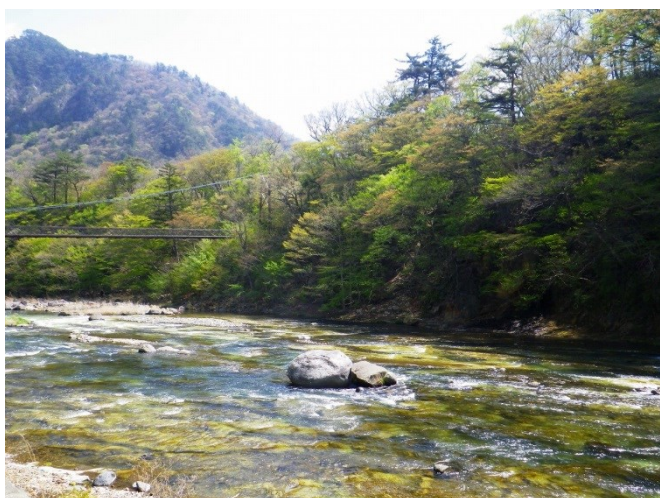
セツ岩吊橋（塩釜地区）
