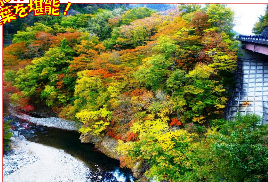
国道 400 号弁天大吊橋から「山ゆりの吊橋」上流を望む
